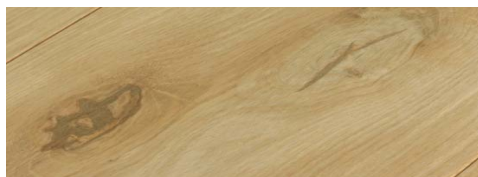
Паркетная доска с дефектом, заделанным Новорит-Фортэ, после шлифования
